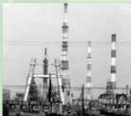
100メートル以上の高煙突の建設
