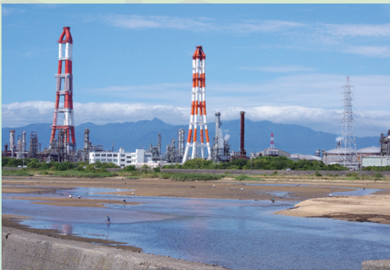
Complexo industrial atual
