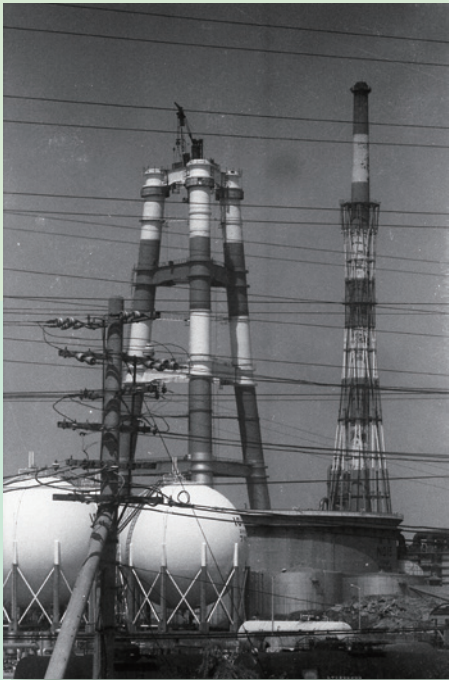
Construção de chaminés altas
